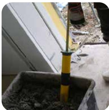
Для равномерного и быстрого заполнения штробы анкеро-ручным составом применяются ручные насосы. Согло насоса погрузить в емкость с готовым к применению составом, заполнить камеру насоса, потянув рукоятку насоса на себя. Подавать материал в штробу обратным движением поршня нажатием на рукоятку.
